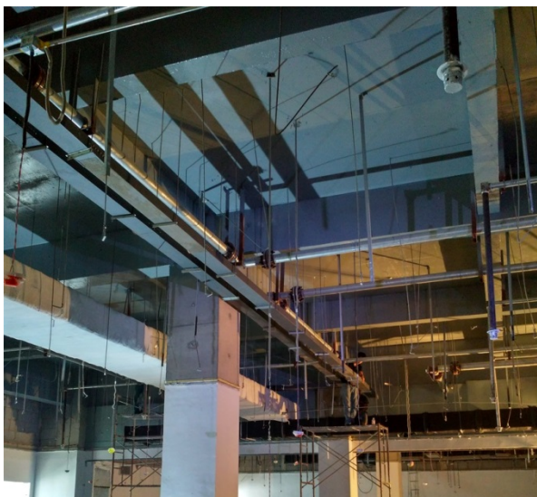
防尘防潮处理
