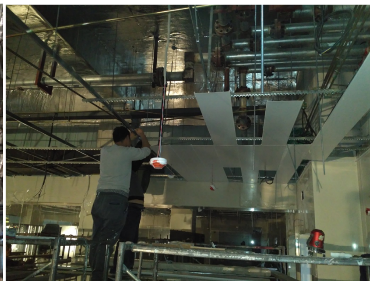
条形天花板，安装格栅灯
