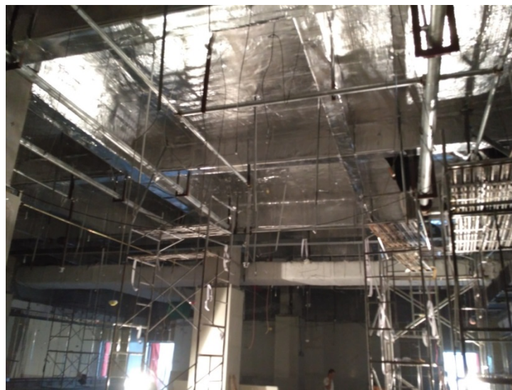
铺设保温板，管路做保温处理，防结露
